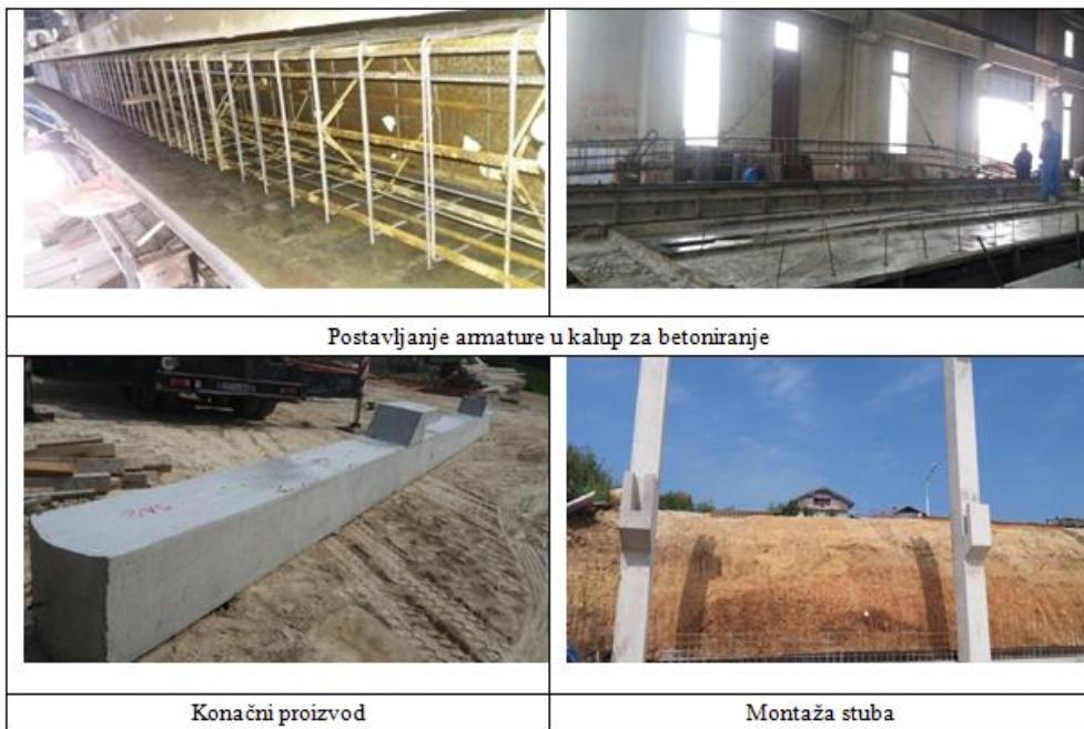
*Slika 23 - Proizvodnja armiranbetonskog stuba*
