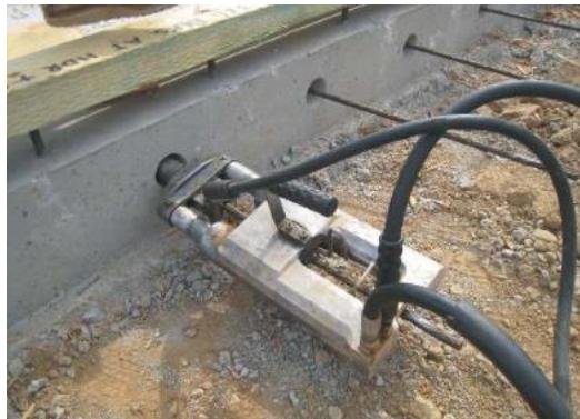
*Slika 13 – Hidraulična presa za naknadno prednaprezanje*
