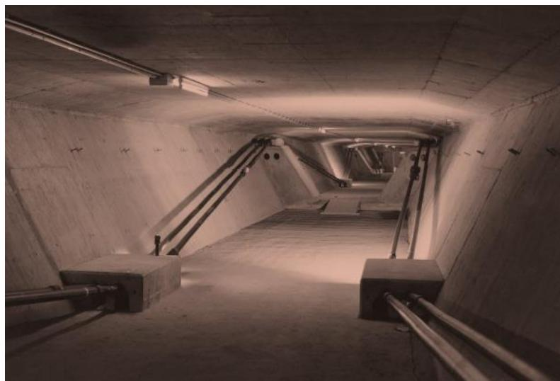
Slika 20 - Vanjsko prednaprezanje poslije očvršćavanja betona [44]
