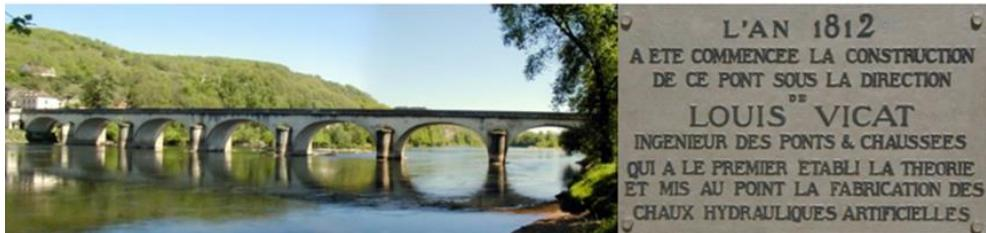
Slika 26 – Prvi most od nearmiranog betona u Souillac-u u Francuskoj 1816. god. [29]
